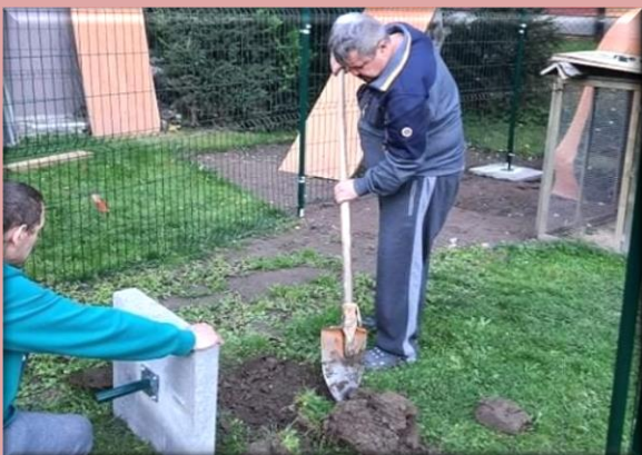
Klienti útulku pracujú na oplotení
