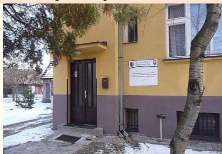
Vstup do Útulku
